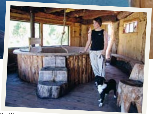
Das Wasser für die großen Badetonnen wird über einen mit Stroh beheizten Heizkessel erwärmt und über Holzleitungen an der Decke direkt in die Tonnen geleitet.
